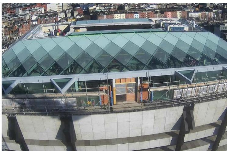
La nouvelle couverture est construite à partir de la structure existante mansardée en treillis. Cette charpente permet la suspension de tirants périphériques qui portent tous les planchers de l'immeuble. Le projet transforme le volume de la toiture technique opaque initiale en un espace abrité sous une enveloppe semi-transparente accueillant des espaces de restauration en rooftop.
